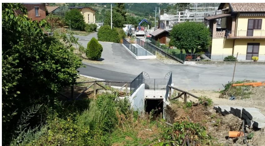
Figura 3 - Fosso di Materceta: in evidenza gli interventi di sistemazione (ampliamento del tombamento e pettini per la ritenzione del materiale solido trasportato dalla corrente)
